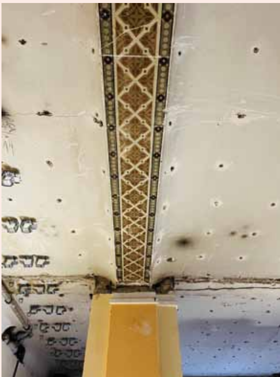
In der Gartenhalle entdeckte das Bauteam beim Freilegen der Decke historische Ornamente.
